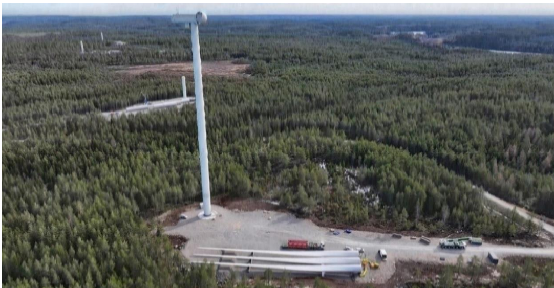
Figur 16 Montage av vindkraftverk, typ Siemens Gamesa SG-170 med 200 m totalhöjd. Exempel på kran- och montageyta. (Foto: Eurowind)
