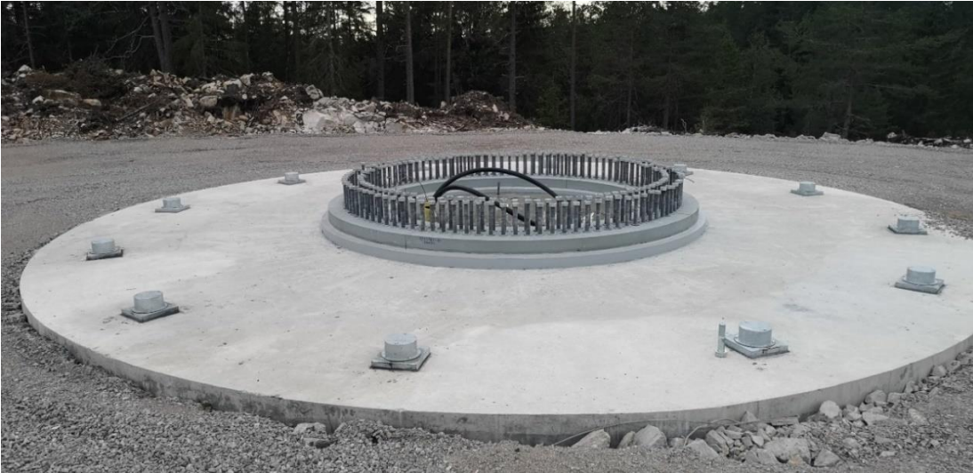
Figur 17 Fundament till ett vindkraftverk, typ Siemens Gamesa SG170 med 200 m totalhöjd.
