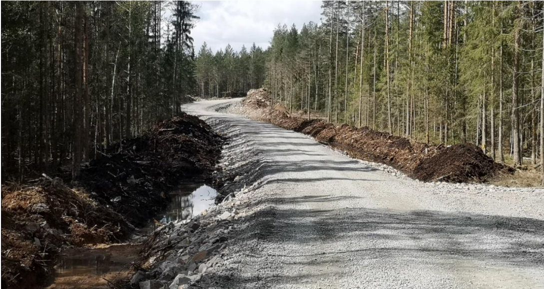
Figur 18 Exempel på breddning av en befintlig väg samt förberedelse för kabelledning utmed vägnät.
